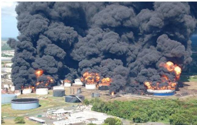
Рис. 38 — Авария на пожаровзрывоопасном объекте
